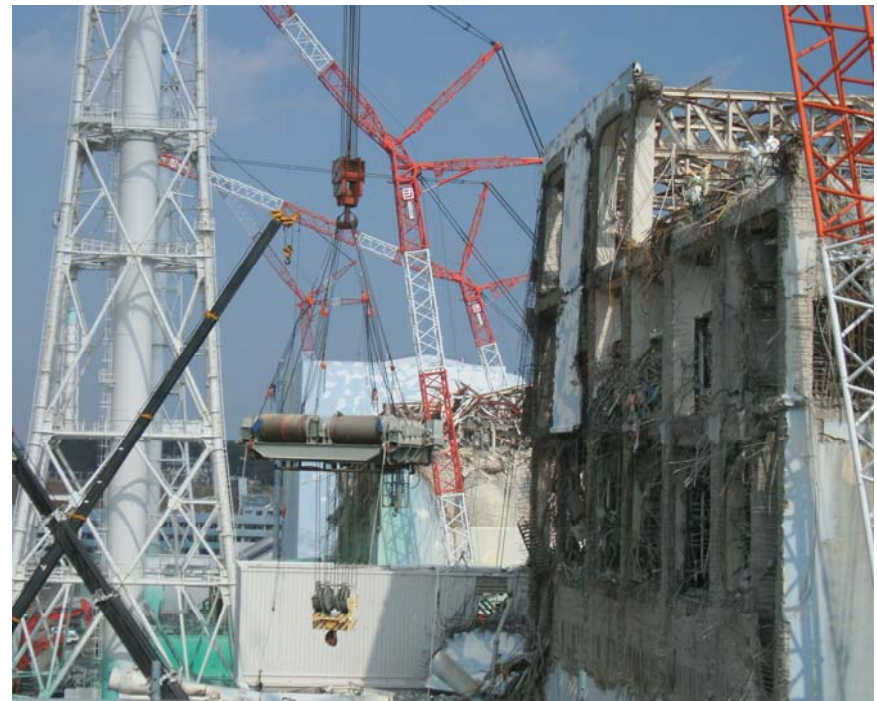
④ 天井クレーントロリー撤去作業(2)
