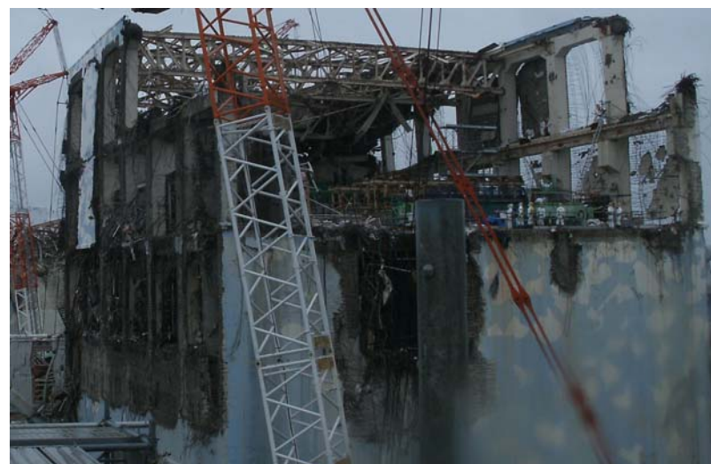
⑨ 天井クレーンガーダー撤去作業(5)
