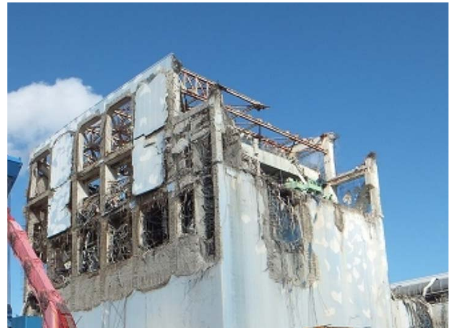
② 4号機原子炉建屋上部ガレキ撤去作業
