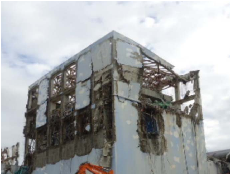
① 4号機原子炉建屋上部ガレキ撤去作業(作業前)
