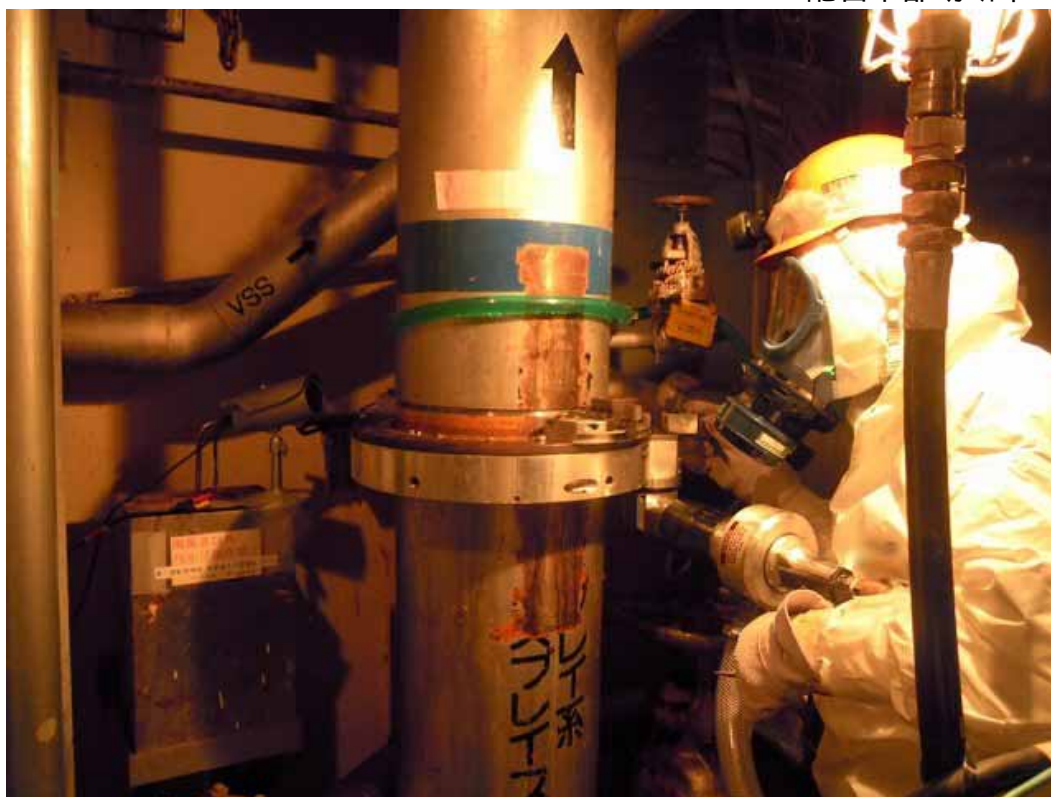
< 配管下部切断中 >
