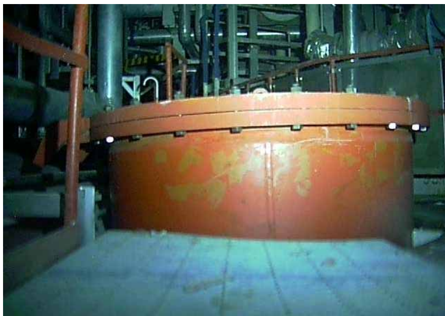
【トラス室北側S / Cマンホール】
