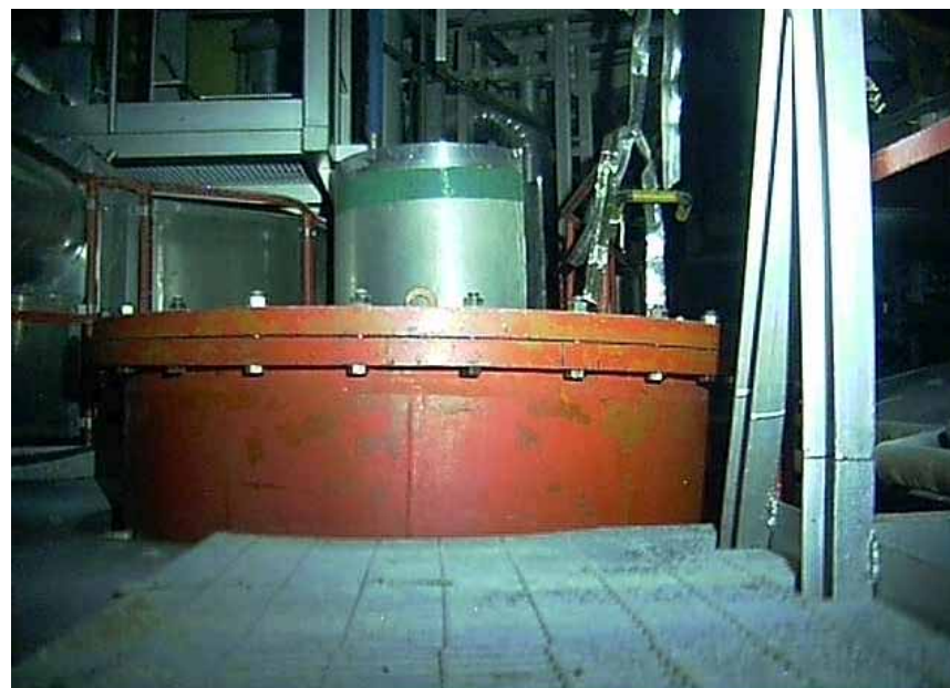
【トラス室南東側S / Cマンホール】
