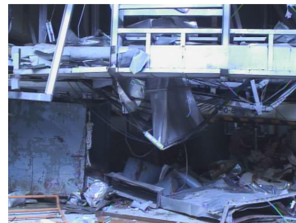
④3階状況 (機器ハッチより撮影)
