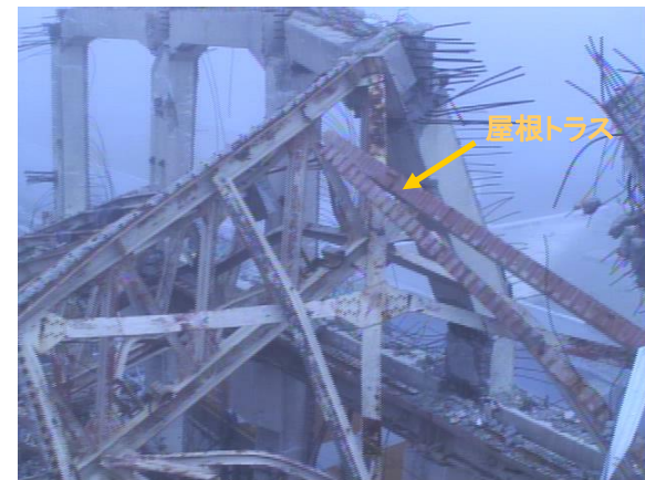
②オペレーティングフロア 東部状況
