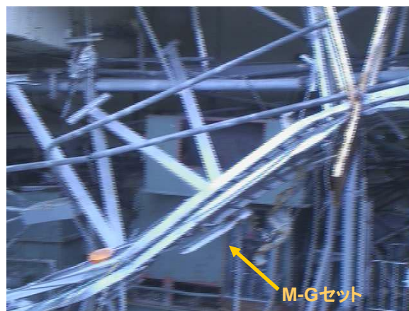
③4階状況 (機器ハッチより撮影)
