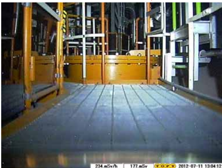
南東マンホール
