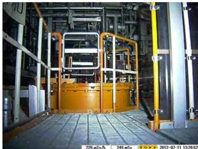
北側マンホール
