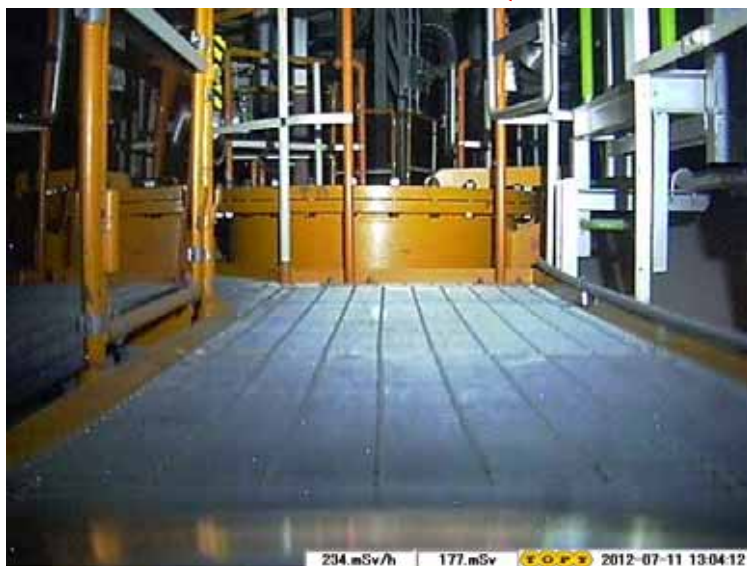
南東マンホール
