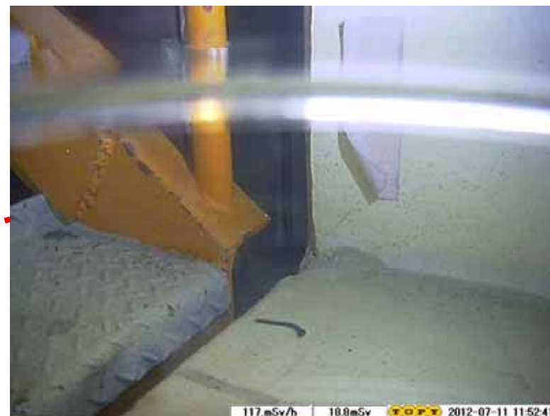
トラス室入口
