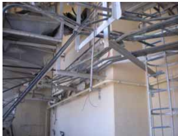
⑨ SFP側壁面（東側）
