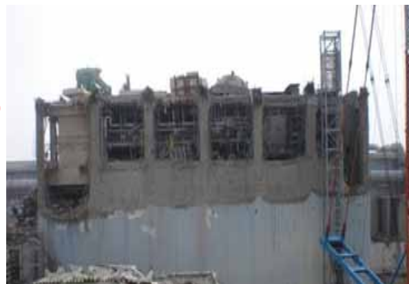
⑤ 西面（外壁）
