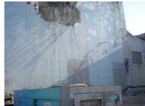
⑥ 南面（外壁）
