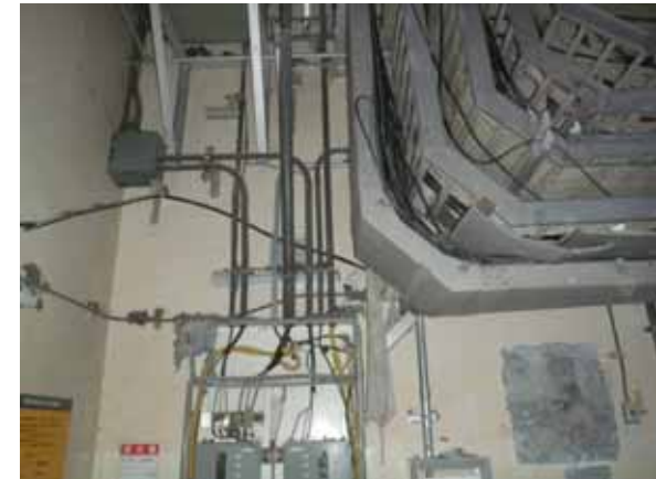
④ 西面（内壁）
