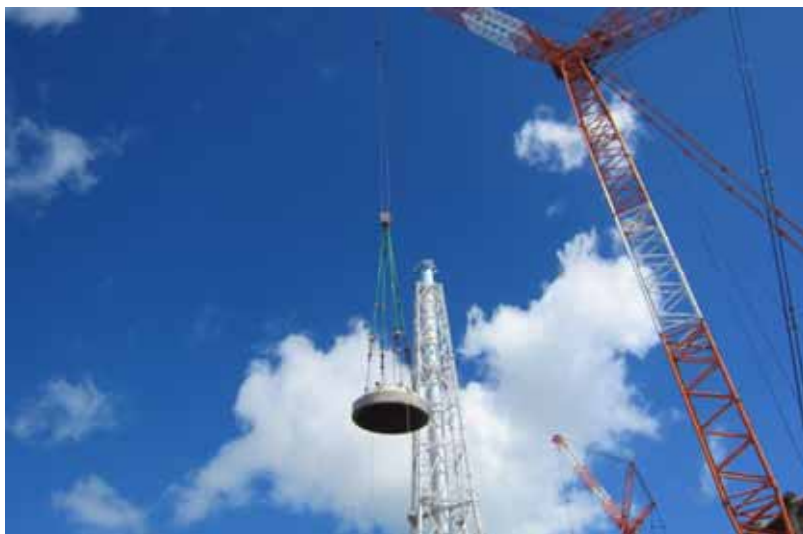
オペフロ上部での吊り上げ作業
