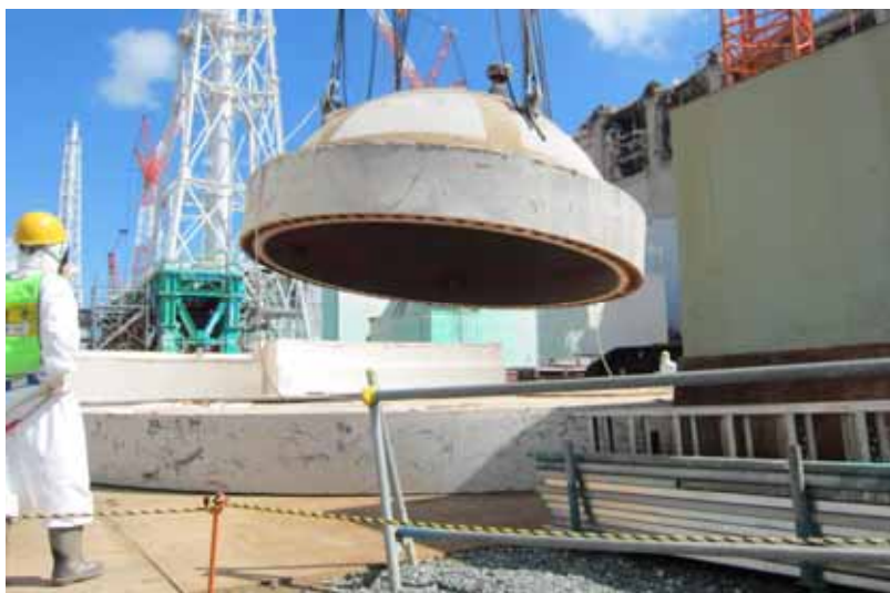
吊り下ろし作業
