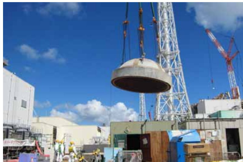
吊り下ろし作業
