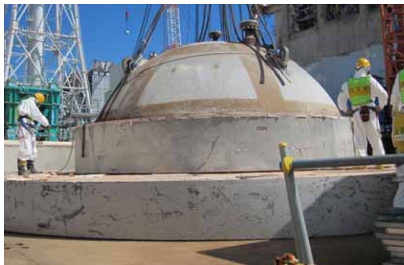
吊り下ろし作業の完了
