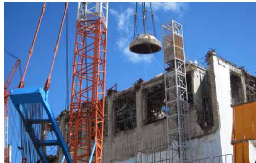
オペフロ上部での吊り上げ作業開始
