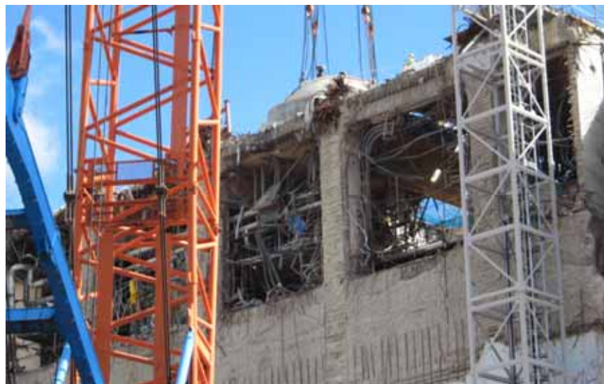
オペフロ上部の圧力容器上蓋
