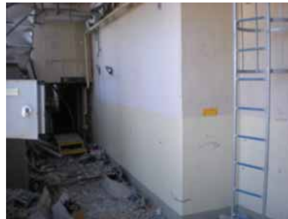
⑨ 使用済燃料プール側壁面（東側）
