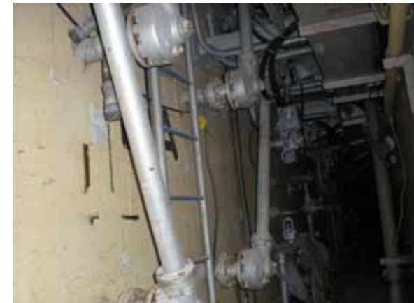
⑧ 使用済燃料プール側壁面（南側）
