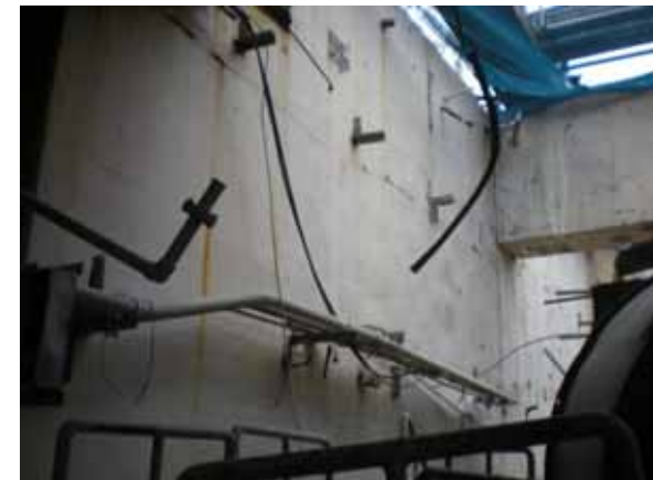
⑩ 使用済燃料プール側壁面（西側）
