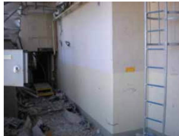
⑨ 使用済燃料プール側壁面（東側）
