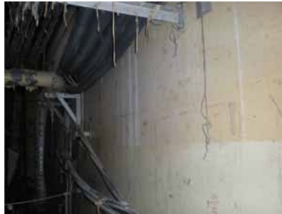
⑦ 使用済燃料プール側壁面（東側）
