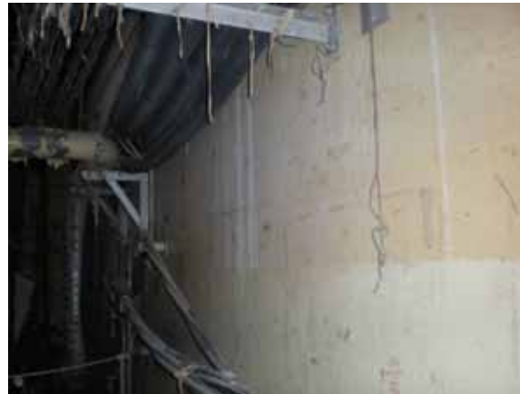
⑦ 使用済燃料プール側壁面（東側）
