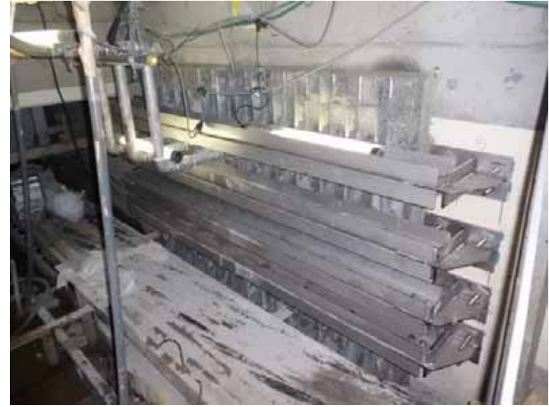
止水工事完了状況 (平成24年12月4日撮影)
