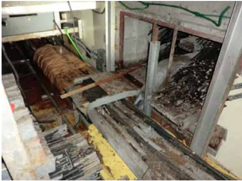
止水工事着手前状況 (平成24年6月11日撮影)
